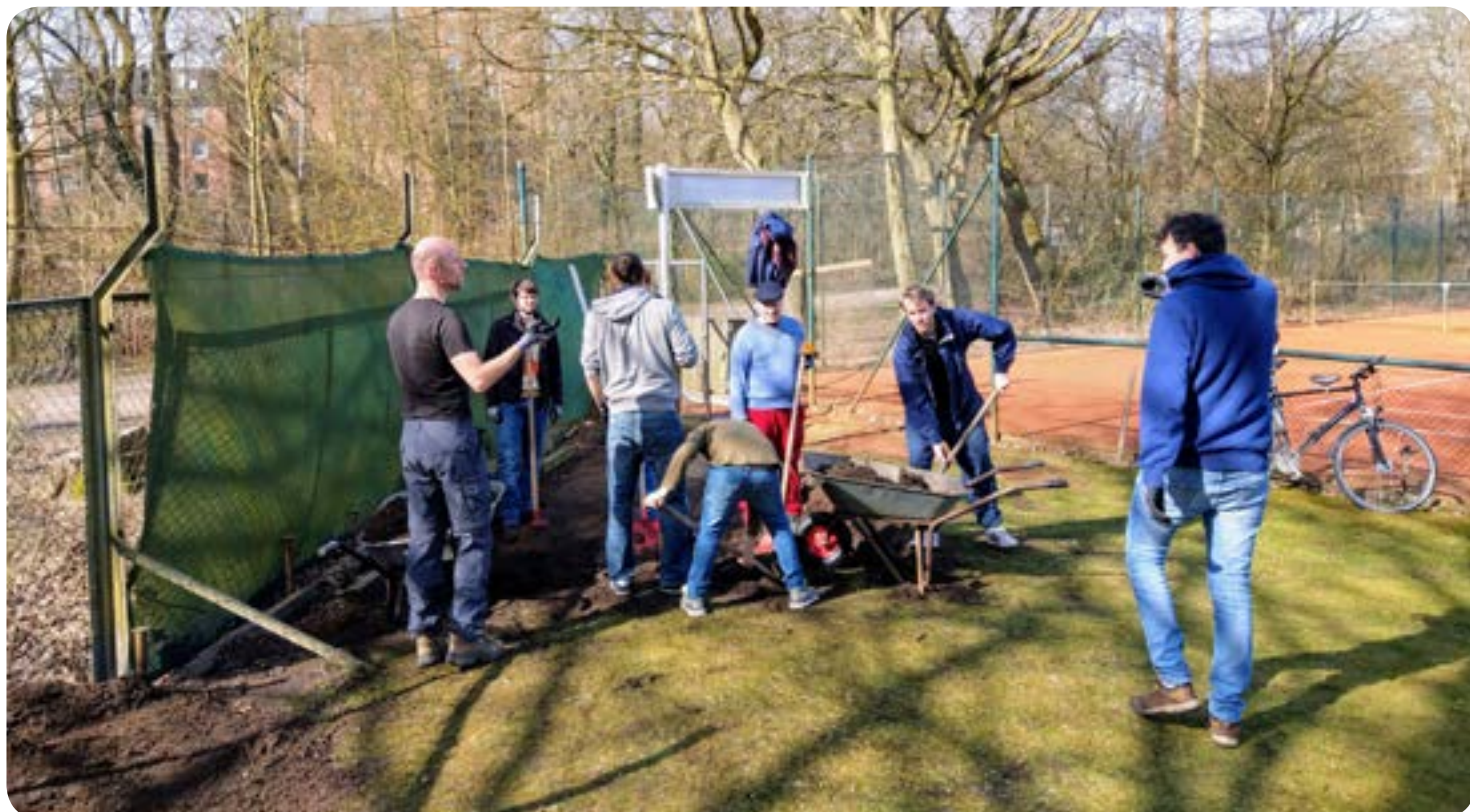
AUSHEBUNG DES FUNDAMENTS FÜR DIE NEUEN SANITÄRANLAGEN
